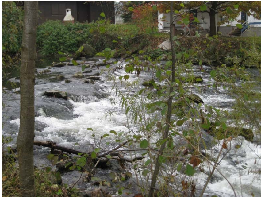
Abbildung 25: Sohlrampe am Innbach.
