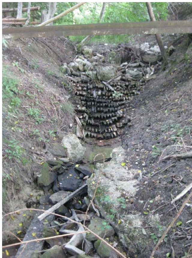
Abbildung 26: Wilde Sohleinbauten in temporäres Gerinne.
